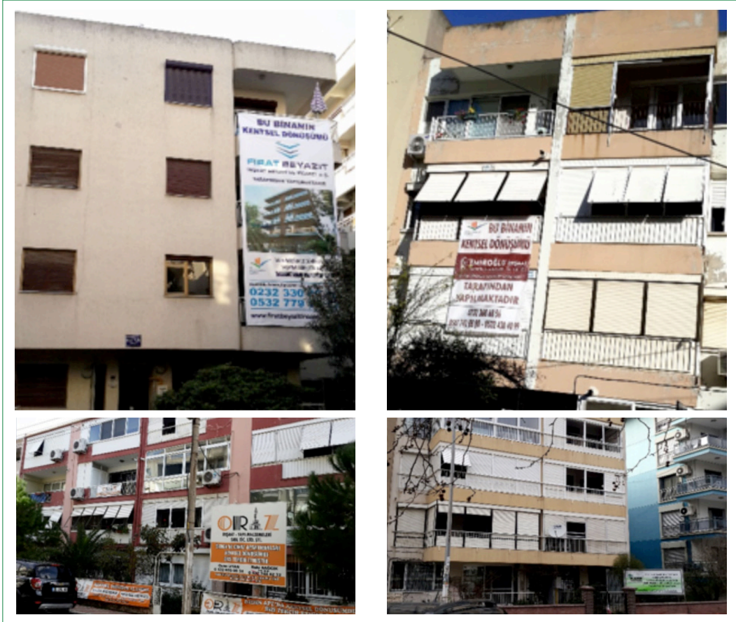
Şekil 4. Anlaşma sağlamış parsellerdeki tabela uygulamaları
