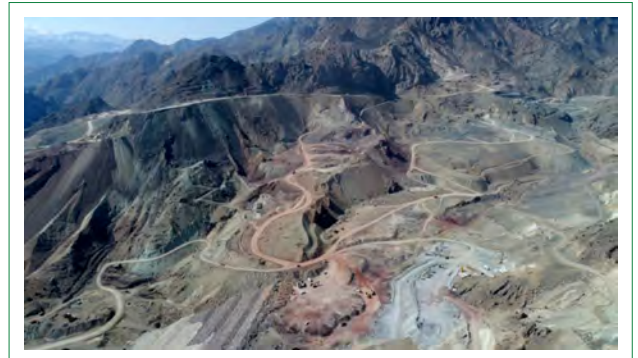
Şekil 18. Yeni yerleşim yerinde yapılan altyapı çalışmaları. Kaynak: DSİ.
