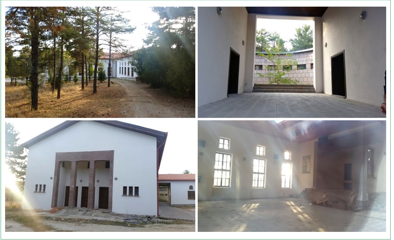
Şekil 4. Müzik Okulu (sinema ve konferans salonu ile müzik odalarından oluşan yapı) (Kaynak: Yazarların arşivi, 2019).
