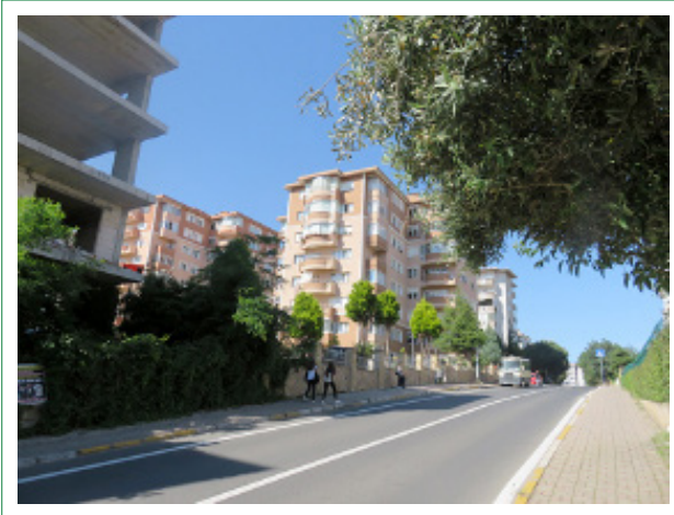
Şekil 5. Hürriyet Mahallesi, Şehit Rüştü Ökeler Caddesi'nden görünüm.
