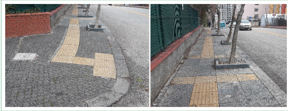
Şekil 10. Çiğdem Mahallesi'nde ana caddeye (1551. Cadde) çıkan sokakta hissedilebilir yüzey uygulamaları (Yazar, 2020).
