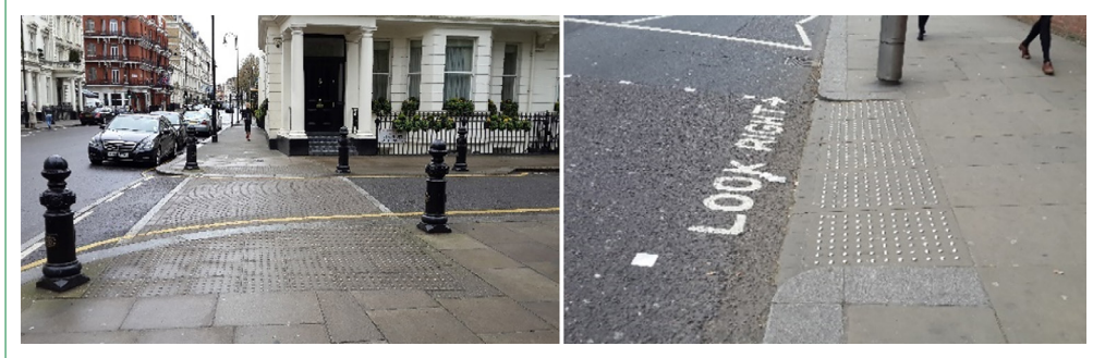
Şekil 12. Londra'da kaldırımda hissedilebilir yüzey uygulamaları (Yazar, 2014).
