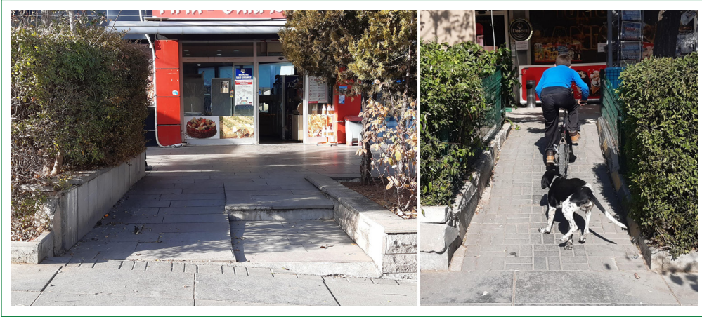
Şekil 7. Atrium İş Merkezi'nde sokağa açılan dükkanlara kaldırımdan rampayla erişim (Yazar, Eylül 2020).
