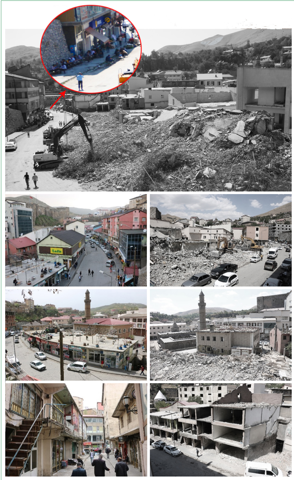
Şekil 7. Çarşının yıkım aşamaları (Kaynak: Bitlis Belediyesi İmar ve Şehircilik Müdürlüğü, 2022).
