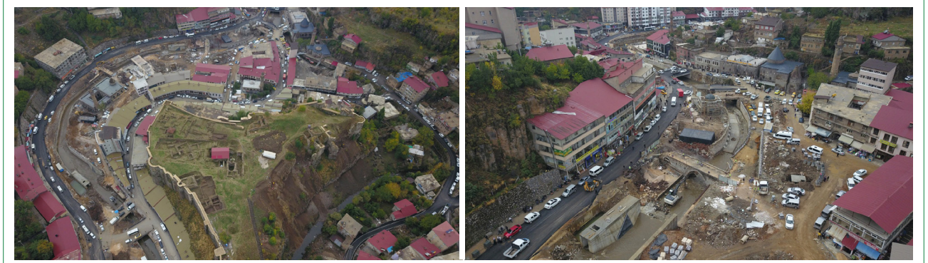
Şekil 10. Bitlis çarşısında kentsel dönüşüm ve restorasyon çalışmaları, 2022 (Kaynak: Bitlis Valiliği, 2022).
