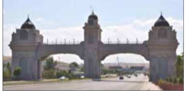
Esenboğa Yolu Kent Giriş Kapısı
