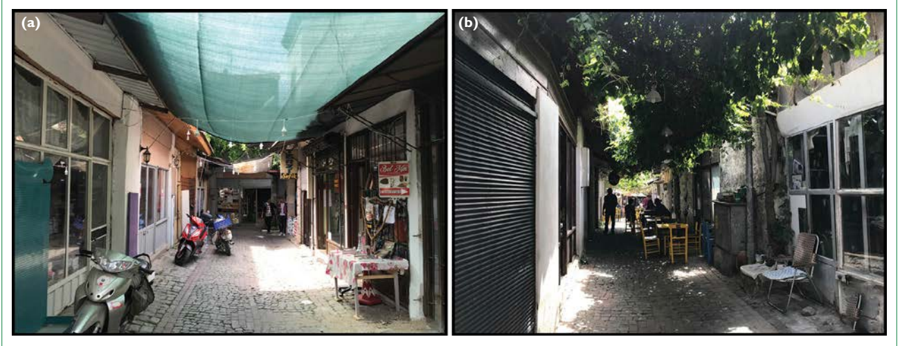
Şekil 20. Urgan Sokak (a) ve Çizmeciler Arastası (b) cephe düzenlemesi yapılmamış olan yapılar.
