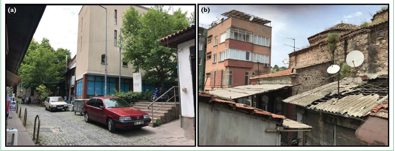
Şekil 19. İplik Pazarı Sokak, Arasta içinde (a) ve Bedestenin karşı cephesinde (b) yer alan çok katlı betonarme yapılar.
