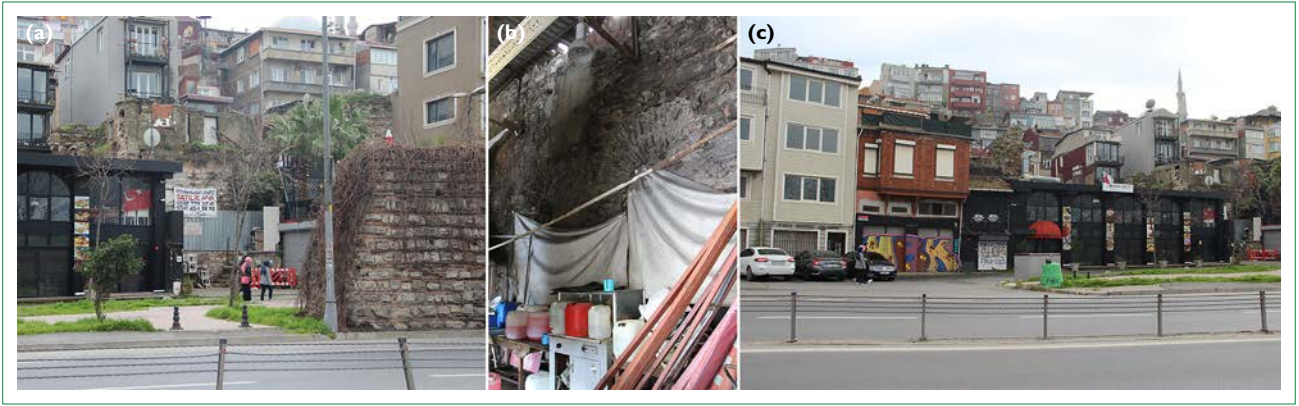
Şekil 31. (a) Yapılar arasında kalmış P4. (b) P4 ve H43 arasında uzanan sur duvarı. (c) H43 burcu batı duvarı kalıntısı.
