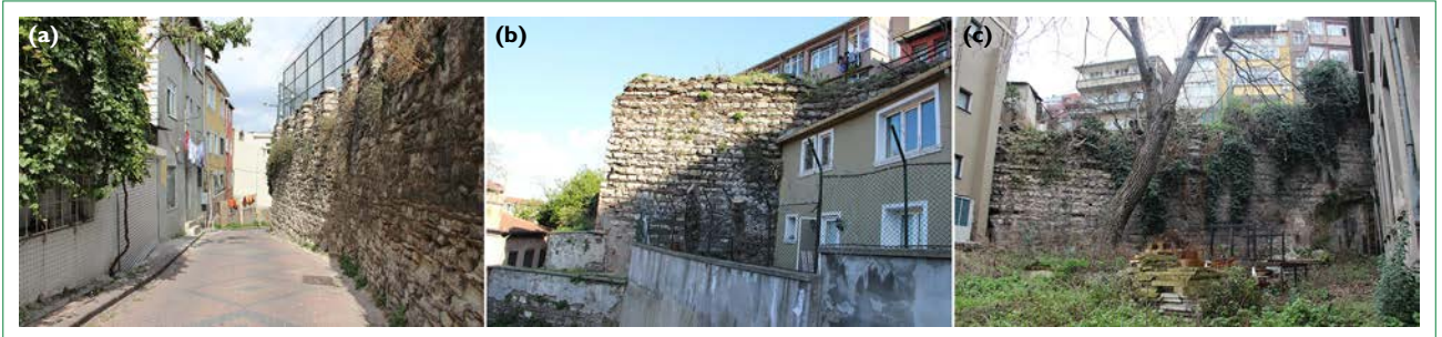
Şekil 30. (a) Petron surları P1 arasında uzanan sur duvarı. (b) P2 ve P3 arasındaki sur duvarı. (c) P3 ve P4 arasındaki sur duvarı.
