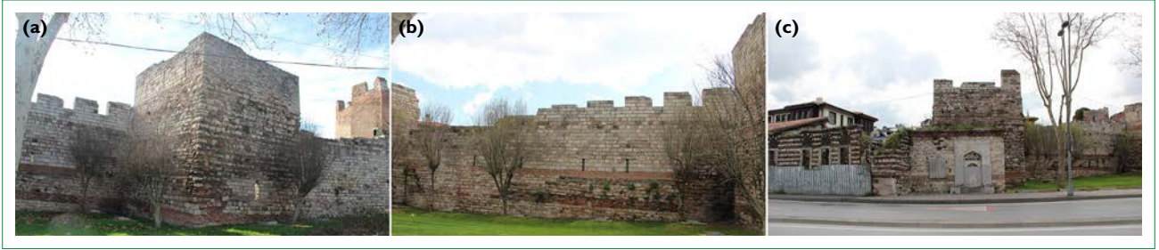
Şekil 10. (a) H1. (b) H1 ve H2 arasındaki sur duvarı. (c) H2.
