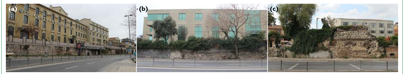
Şekil 38. (a) Günümüze ulaşmamış H57-H60 arasındaki sur duvarları. (b) H60-H61 arasındaki sur duvarı üzerinde Tüfenkhane Kapısı izleri. (c) H60-H61 arasındaki sur duvarının son kalıntısı.
