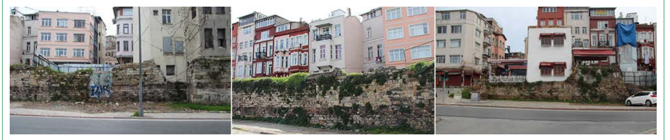
Şekil 23. Sırasıyla H31 ve 32 arasındaki sur duvarı.
