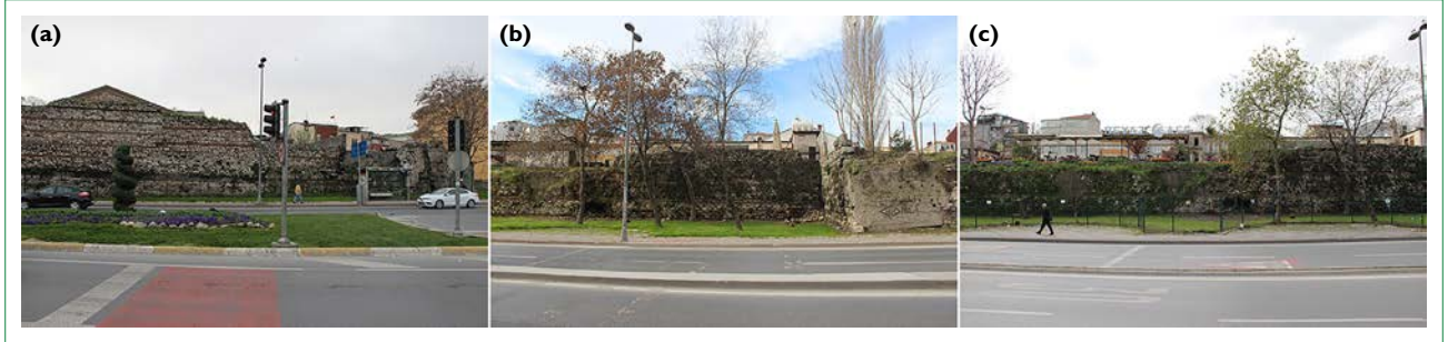
Şekil 15. (a) H11. (b) H12-13. (c) H13-H14 burçları arasında bütüncülüğünü koruyan sur duvarları.
