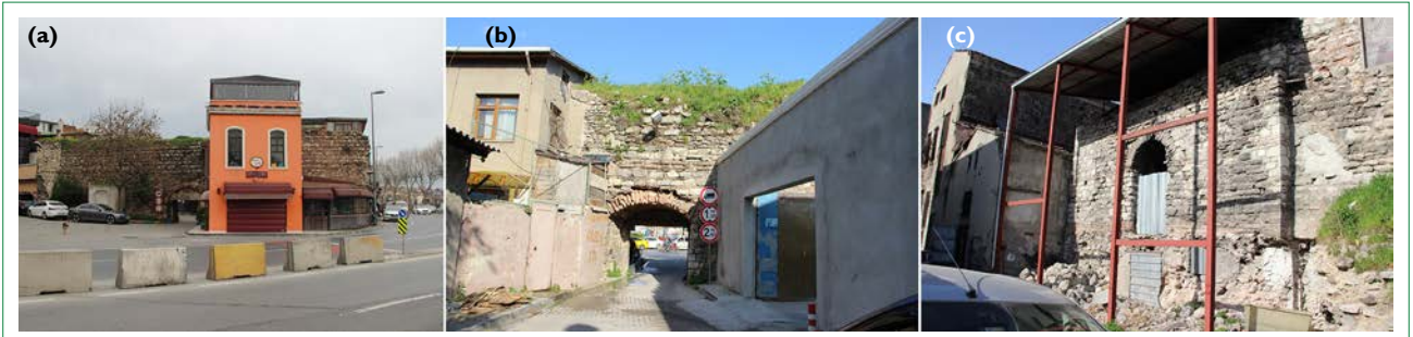
Şekil 34. (a, b) Sırasıyla günümüze ulaşmamış H48-H50 arasındaki Ayakapı'nın denize bakan cephesi ve kent içine bakan cephesi. (c) H52.
