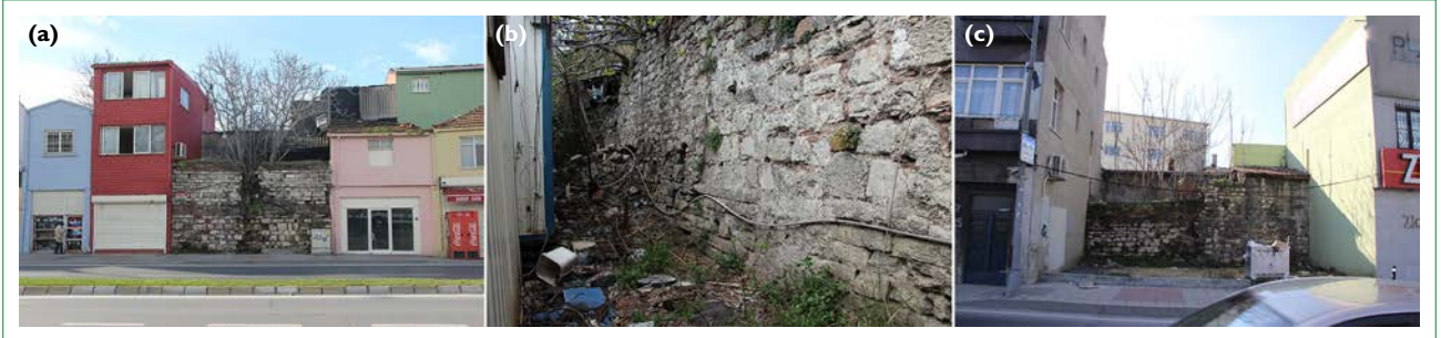
Şekil 13. (a, b) Sırasıyla H5; H5 ve H6 arasındaki görünürlüğü zayıf durumda olan sur duvarı. (c) H8 ve H9 arasındaki sur duvarı.
