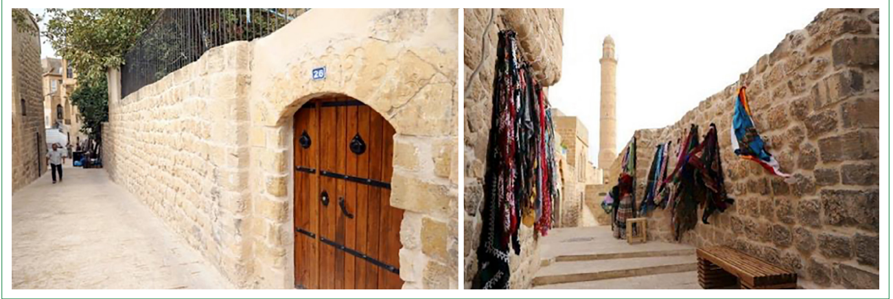
Şekil 14. Sokak sağlıklaştırma çalışmaları.
