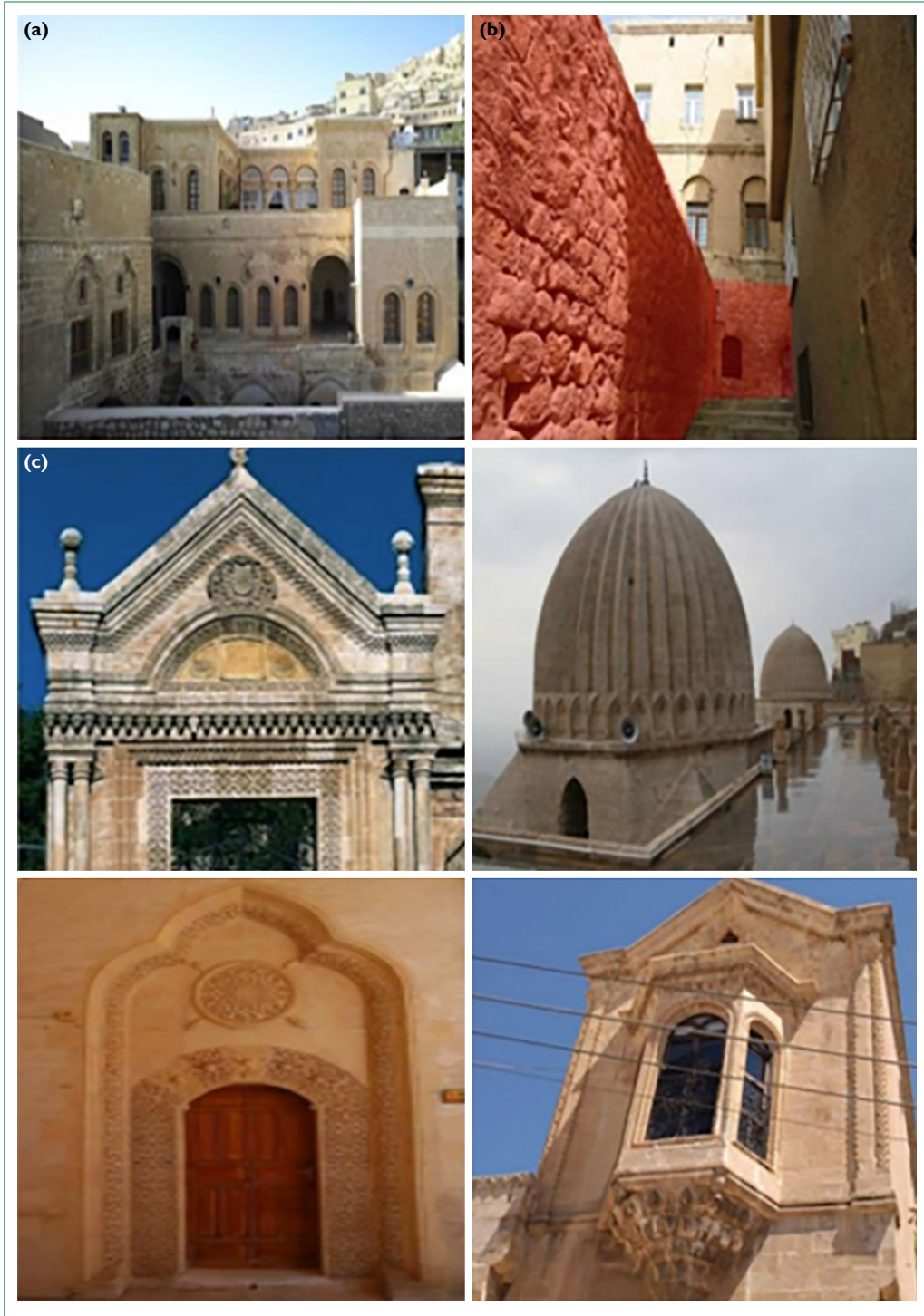
Şekil 11. Mardin kent merkezinde kullanılan malzeme ve formları: (a) Kesme taş (b) Kabaca yontulmuş taş (c) Bezeme amaçlı kullanılan taş (Kişisel Arşiv&KUDEB, 2018).
