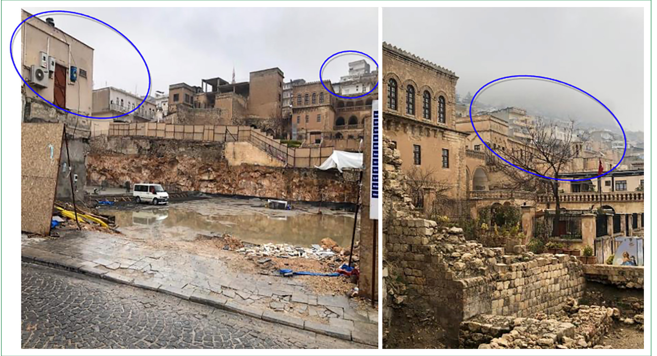
Şekil 16. Mardin kent dokusuna aykırı yapılar (Sırma Turgut kişisel arşivi, 2020).
