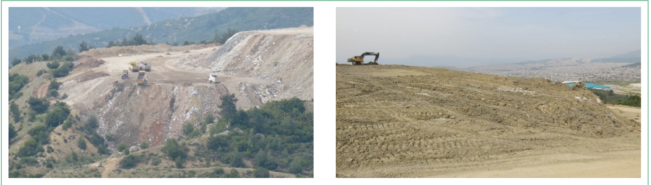
Şekil 6. Bucak-Kırıklar ve Gaziemir inşaat harfiyat döküm alanı dolun süreci.
