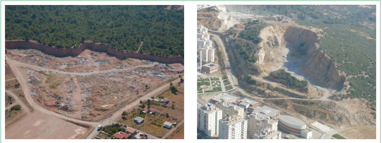
Şekil 5. Bucak-Kırıklar ve Gaziemir inşaat harfiyat döküm alanı.
