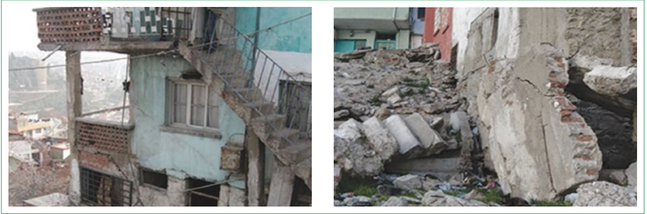
Şekil 4. Kadifekale kentsel dönüşüm projesi yıkım süreci.
