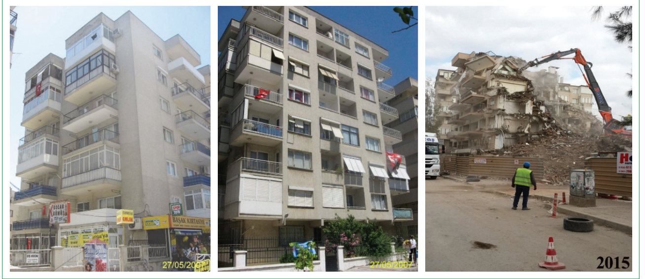
Şekil 8. Bornova Yücel-Aydoğan Apt. kentsel dönüşüm öncesi ve yıkım süreci.
