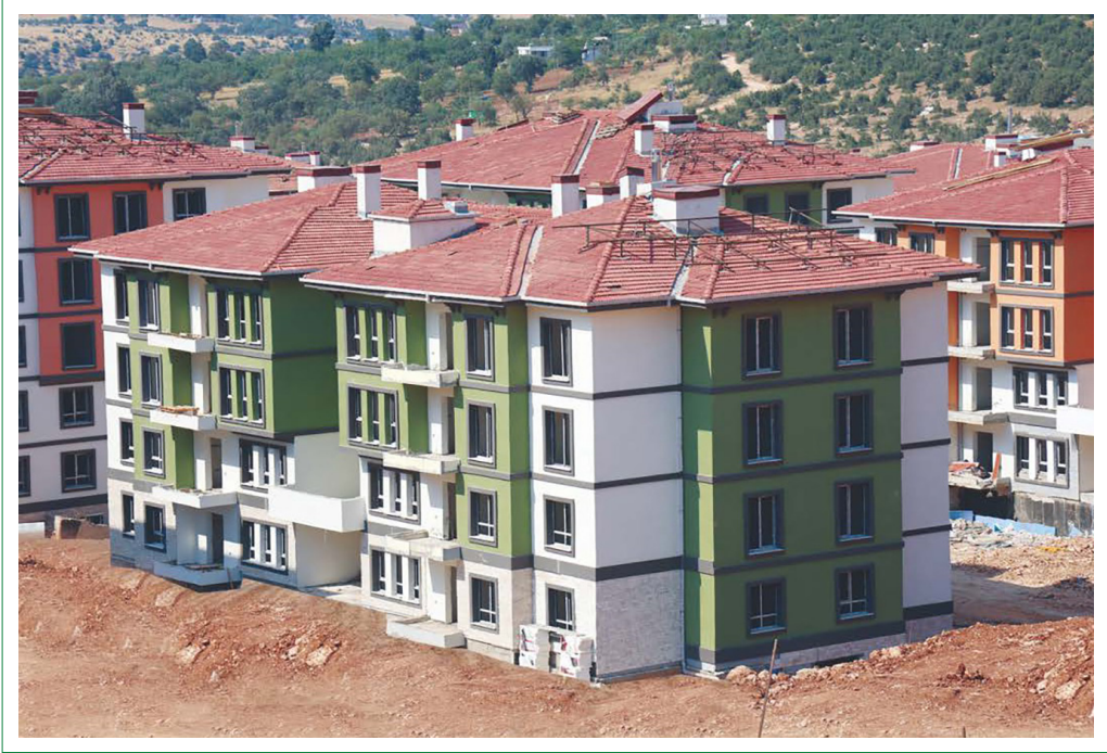
Şekil 3. TOKİ Kahramanmaraş deprem konutları (TOKİ Haber, 2024).
