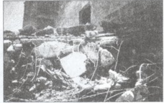
Şekil 7. Moloz yığını haline gelen betonarme yapı
