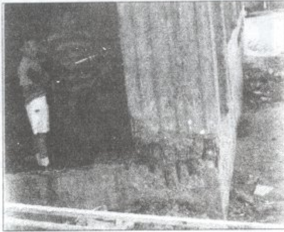
Şekil 13. Binadaki beton dayanımı
