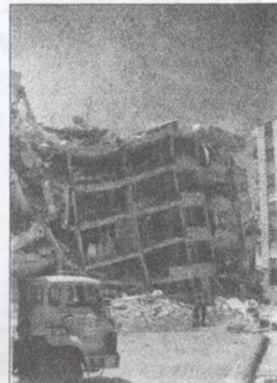
Şekil 3. Ceyhan'da Yıkılmış yapıdan bir görünüş
