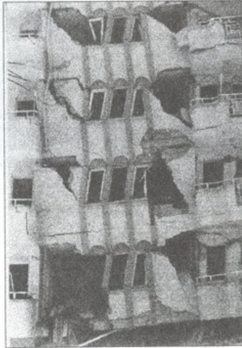
Şekil 23. Titreşim moduna uygun hasar
