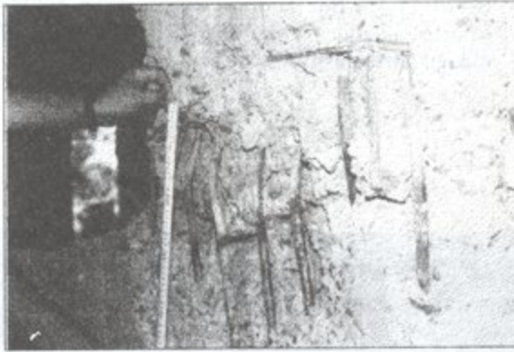
Şekil 14. Burkulmuş olan paslı boyuna donatılar ve etriye aralığı
