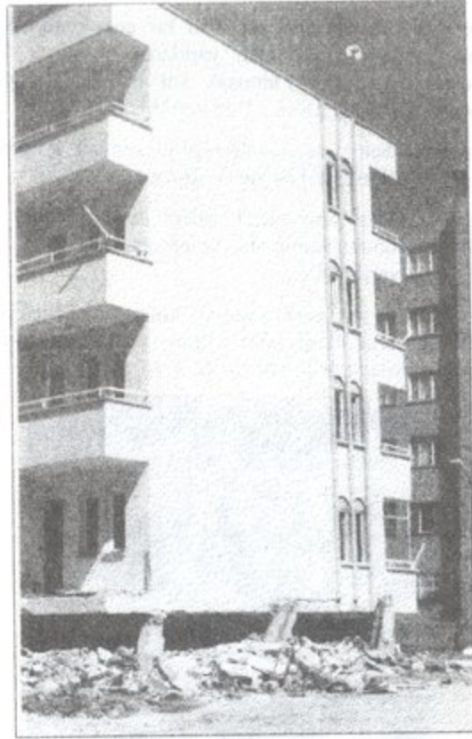
Şekil 22. Yumuşak kat davranışı
