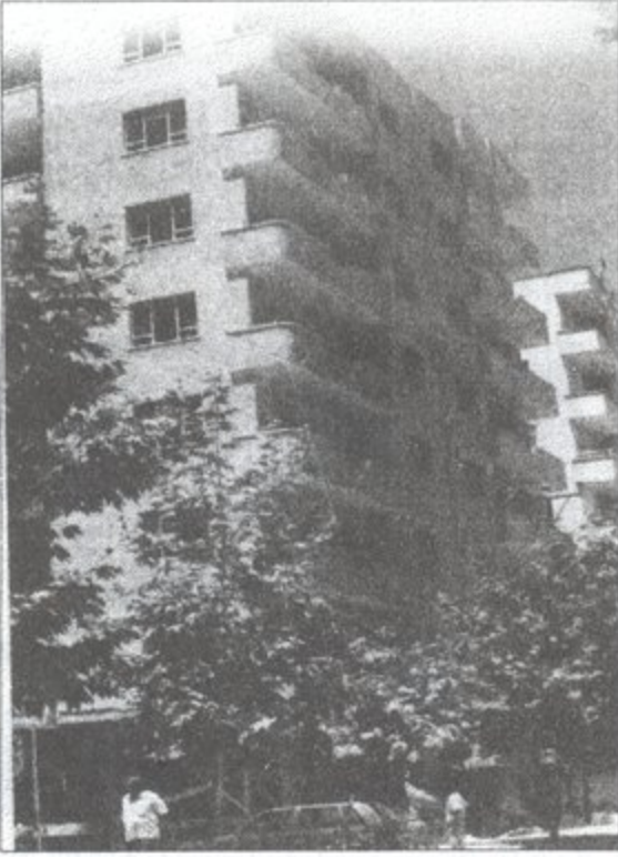
Şekil 10. Bazı kolonları hasar gören 8 katlı yapı
