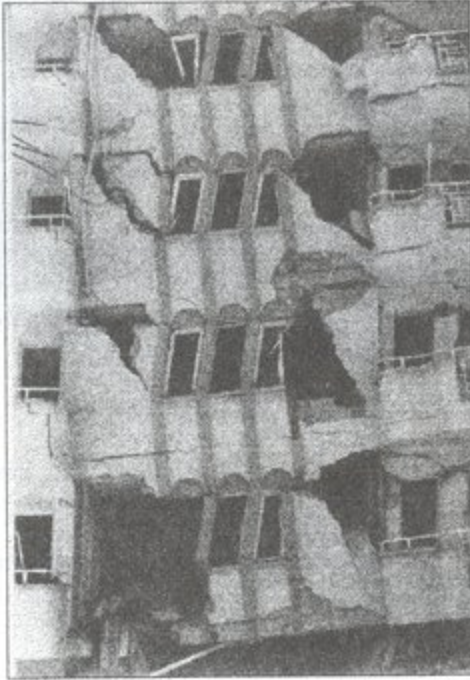
Şekil 23. Titreşim moduna uygun hasar
