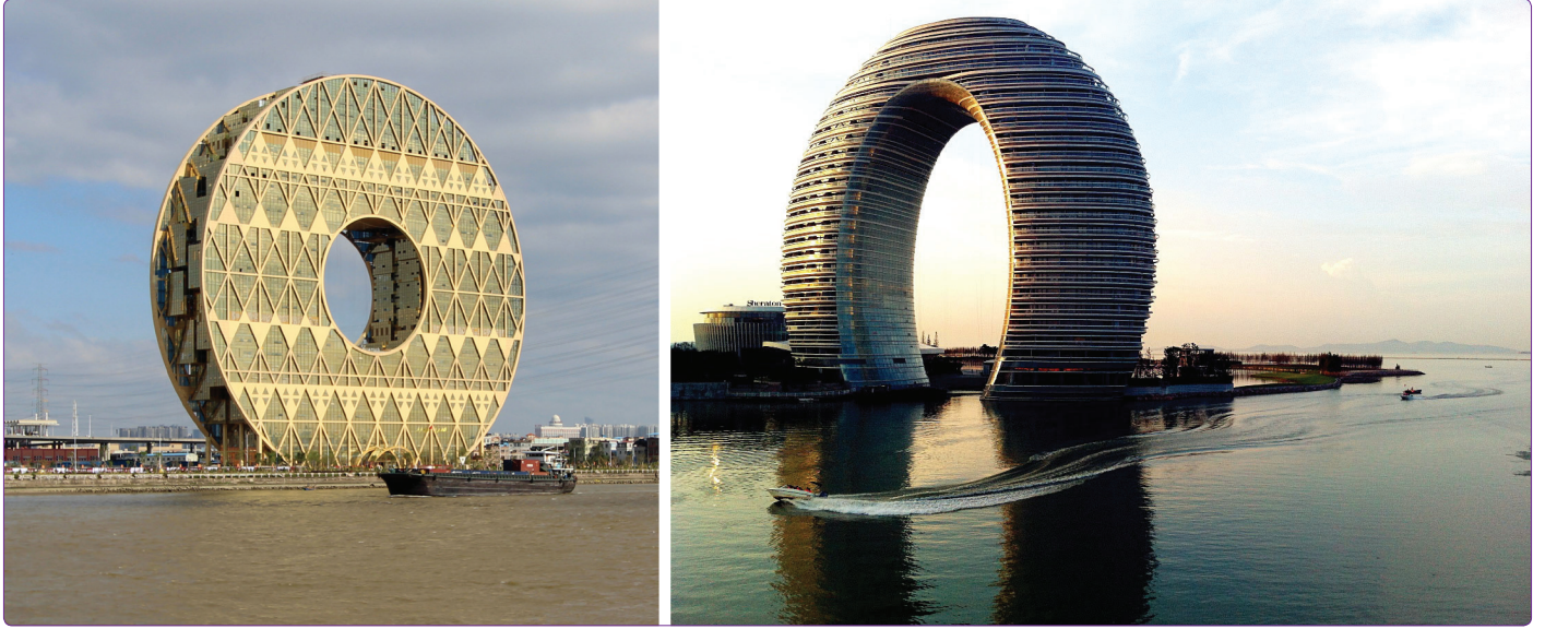
Şekil 3. Solda Guangzhou Circle (Kaynak: https://commons.wikimedia.org/wiki/File:Guangzhou_Circle_3.jpg ), sağda Starwoodhotels in Huzhou (Fotoğraf: MAD China) (Kaynak: https://commons.wikimedia.org/wiki/File:Starwoodhotels_in_Huzhou.jpg ).
