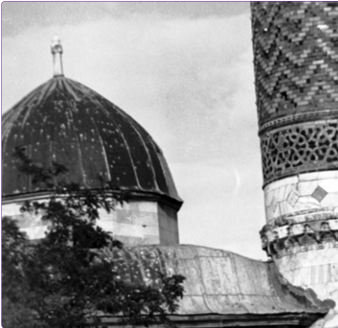
Şekil 9. Bursa, İznik, Yeşil Camisinin (M.1391/2) son cemaat yeri kubbe- bensi orta tonozunda yer alan prizmatik bir çubuk biçiminde taş alem detayını gösterir fotoğraf (Kaynak: Vakıflar Genel Müdürlüğü Arşivi, 2016).
