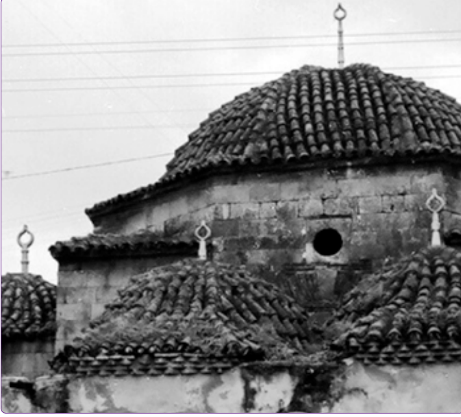
Şekil 2. Adana, Merkez, Kemeraltı Camisinde (M.1548) taş alemleri gösterir fotoğraf (Kaynak: Vakıflar Genel Müdürlüğü Arşivi, 2016).
