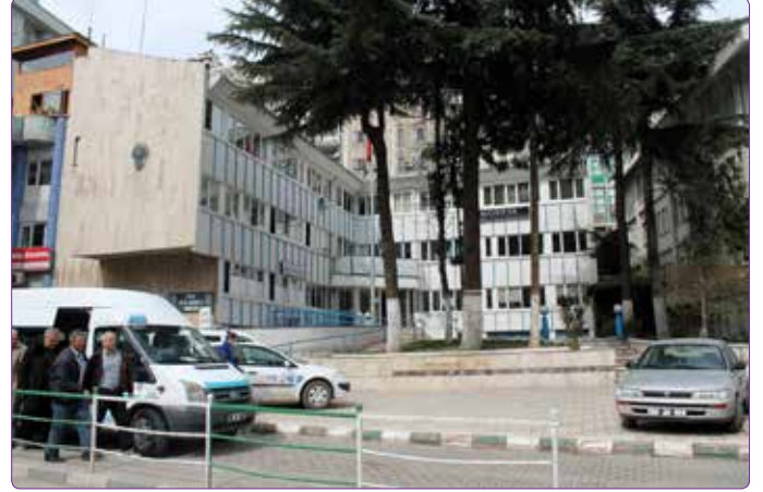
Şekil 24. Emniyet Müdürlüğü Binası'nın İnönü Caddesi'nden görünüşü (Güler, 2015).
