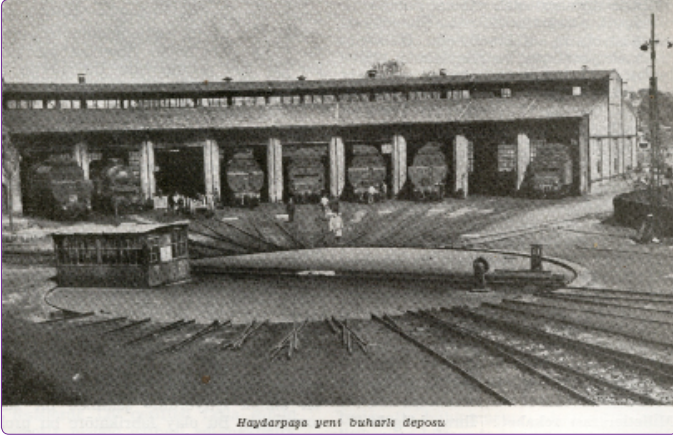
Şekil 16. Demiryol Dergisinde (1960) "Haydarpaşa Yeni Buharlı Deposu" başlıklı yayınlanan resim.
