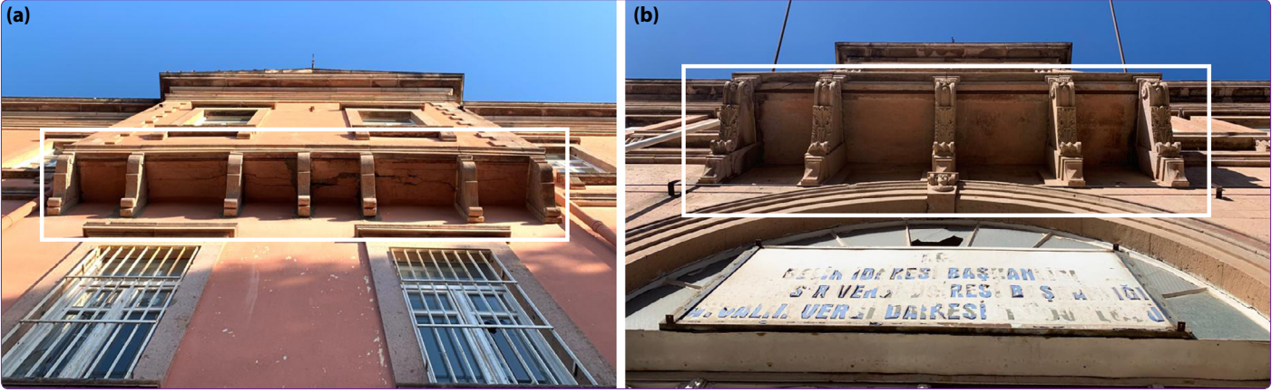
Şekil 13. (a) Yapının bahçe cephesindeki bozulma sonucu açığa çıkan çıkma altı detayı; (b) Benzer detayda kurgulandığı düşünülen giriş cephesi üzerindeki cumba detayı.
