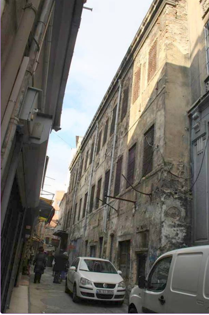
Şekil 5. Tarihi binanın mevcut halinden bir görünüm.
