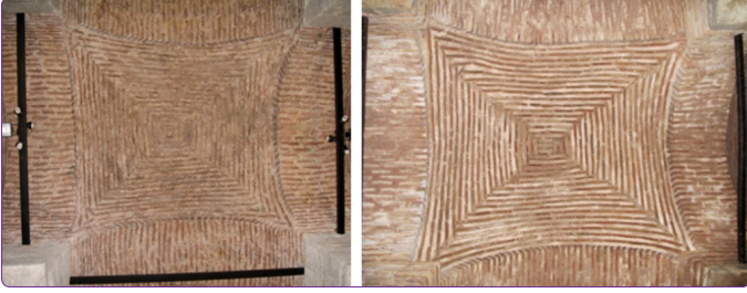
Şekil 16. İstanbul sarnıçlarından çapraz tonoz örnekleri [Sultan Sarnıcı (Bonos Sarnıcı?) ve Yerebatan (Bazilika) Sarnıcı] (Altuğ, 2013).
