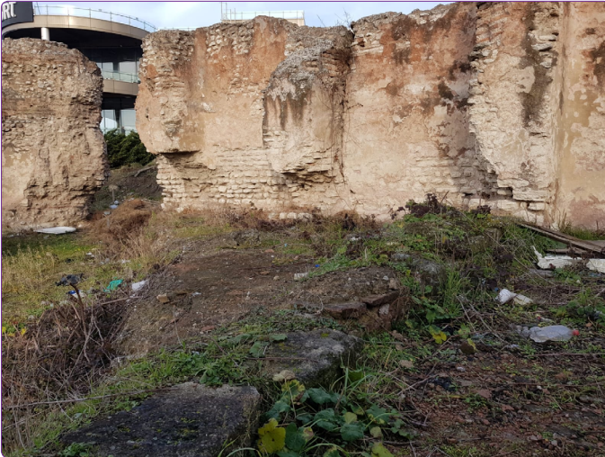
Şekil 7. İç mekânı bölen duvar kalıntısı (Altuğ, 2020).
