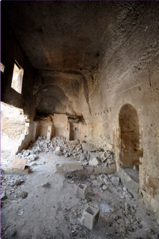
Şekil 13. Çevredeki Kaya Yerleşimleri.
