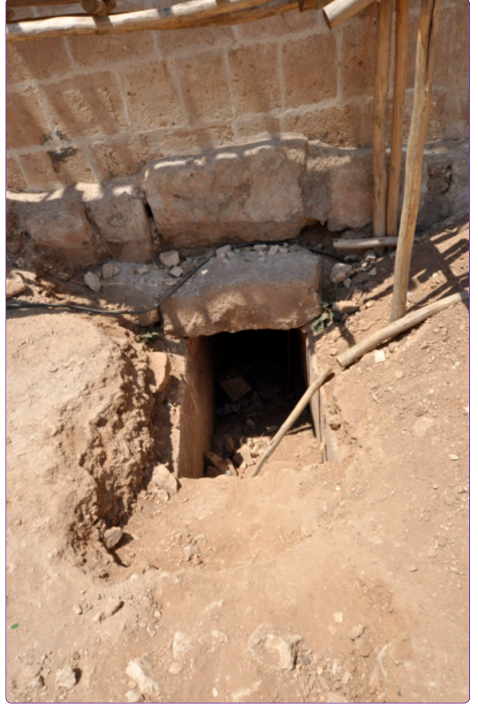
Şekil 10. Doğu Cephesi – Mezar Odası Girişi.
