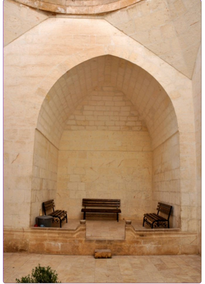
Şekil 8. Avlu – Batı Eyvanı son tamirden sonra.
