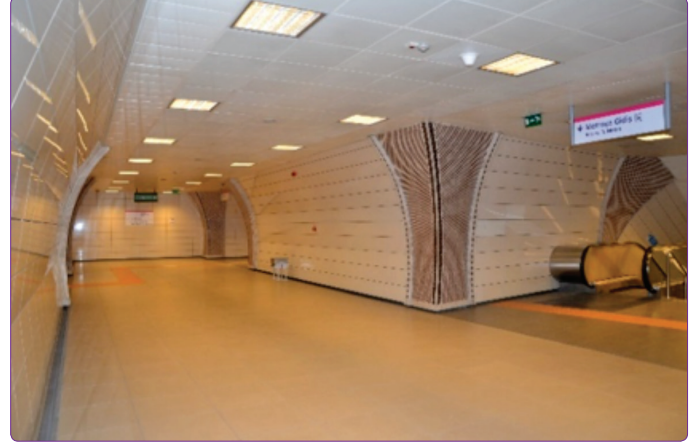
Şekil 21. Kartal Metro İstasyonu'nda duvar kaplaması.
