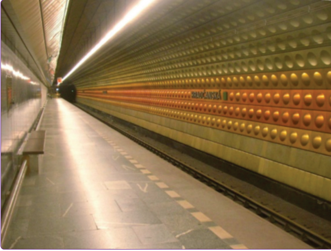
Şekil 8. Prag Hradcanska Metro İstasyonu. 27
