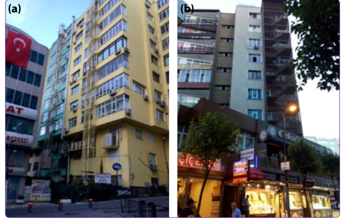
Şekil 8. (a) Dairesel merdiven kullanımı. (b) Merdivenin aydınlatılmaması.
