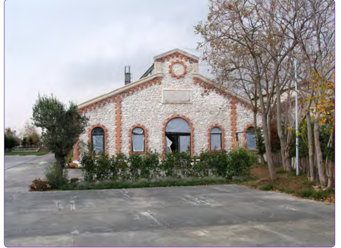
Şekil 22. 1. Bölümün restorasyon sonrası Güneydoğu cephesi (Kıraç arşivi, 2016).
