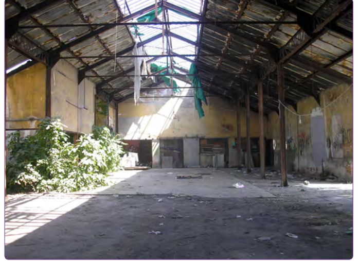
Şekil 15. 1. Bölüm taşıyıcı sistem konstrüksiyonu (Restorasyon öncesi), (Kıraç arşivi, 2011).
