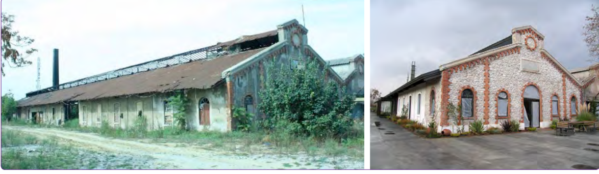
Şekil 23. Eski (solda) ve Yenilenmiş (sağda) Güneydoğu cephesi (Kıraç arşivi, 2011, 2016).
