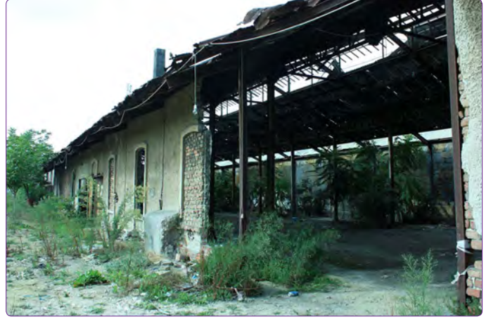
Şekil 31. 1. Bölüm Güneybatı cephesi (Restorasyon öncesi) (Kıraç arşivi, 2011).
