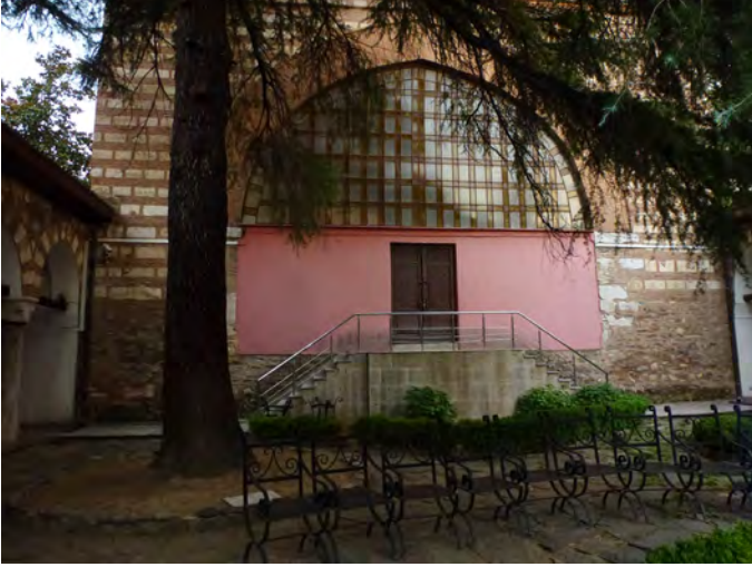
Şekil 7. Avludan ana eyvan/derslik cephesinin görünüşü.
