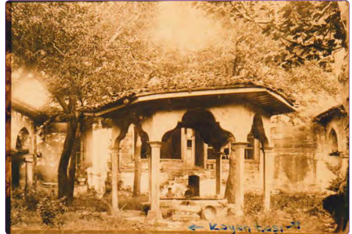
Şekil 17. Avluda şadırvan ve ana eyvana giriş (Bursa Kültür Varlıklarını Koruma Bölge Kurulu arşivinden alınan bu fotoğrafta, dershanenin altında basık kemerli girişi olan bir mekan tespit edilmiştir).
