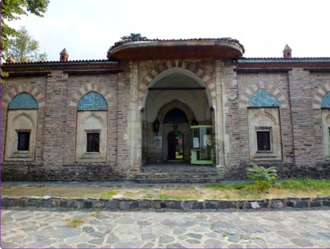
Şekil 4. Medresenin kuzeybatı cephesi/giriş eyvanı.
