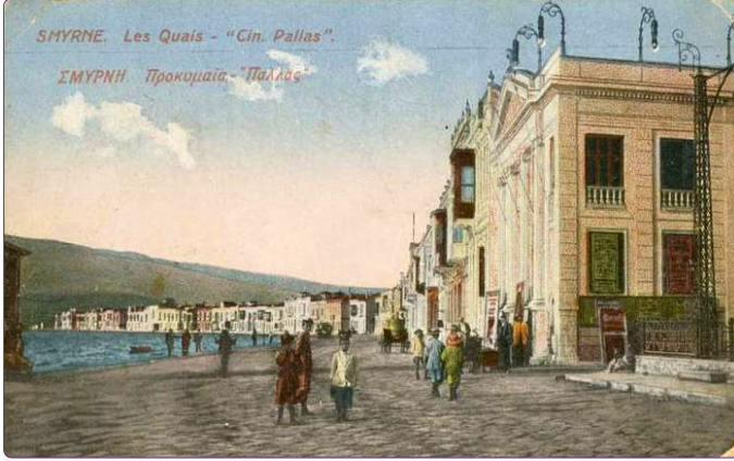
Şekil 11. Yapının yan cephesinin en azından başlangıcında ön cephe- deki düzenin devam ettiği görülmektedir. 26
