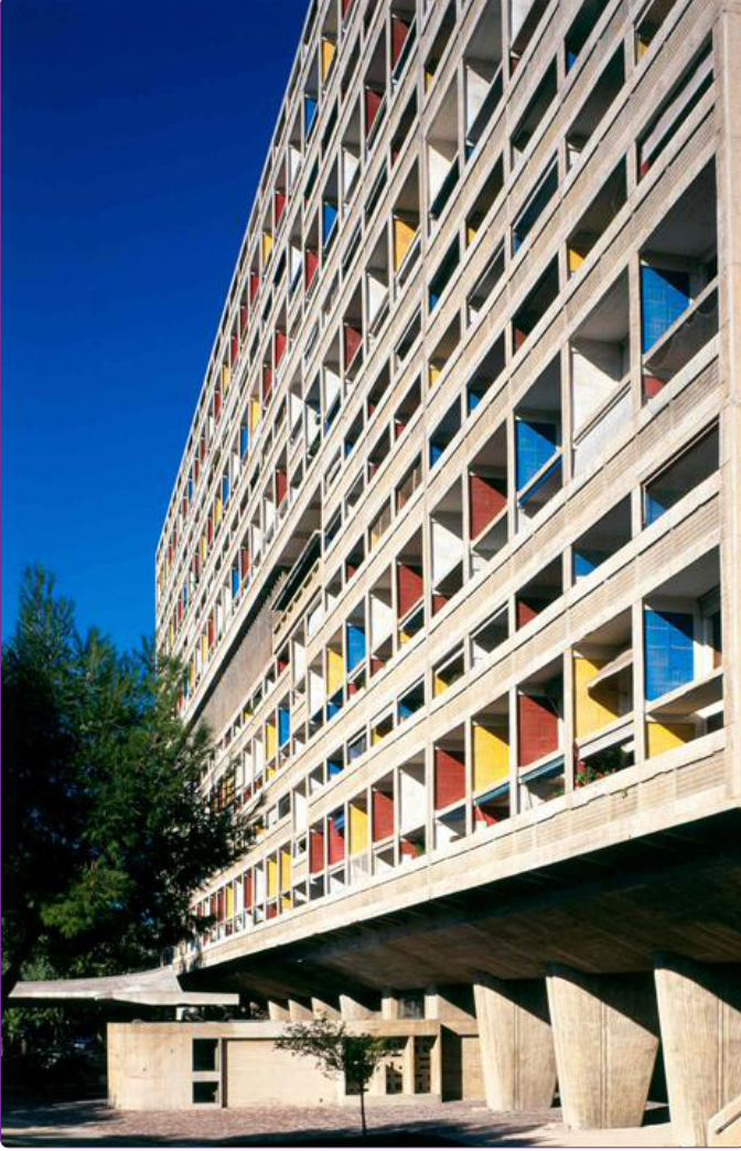
Şekil 3. Unite d' Habitation, cepheden görünüş (Dezeen Official Website, 2016).
