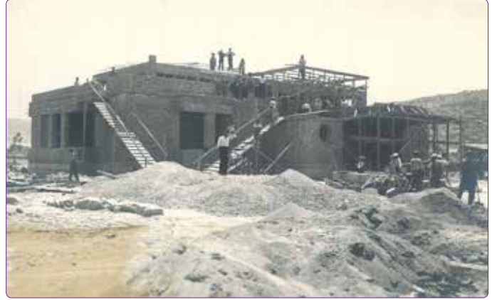
Şekil 5. İzmir Sağlık Sergisi binasının inşaatı (Kaynak: APIKAM).
