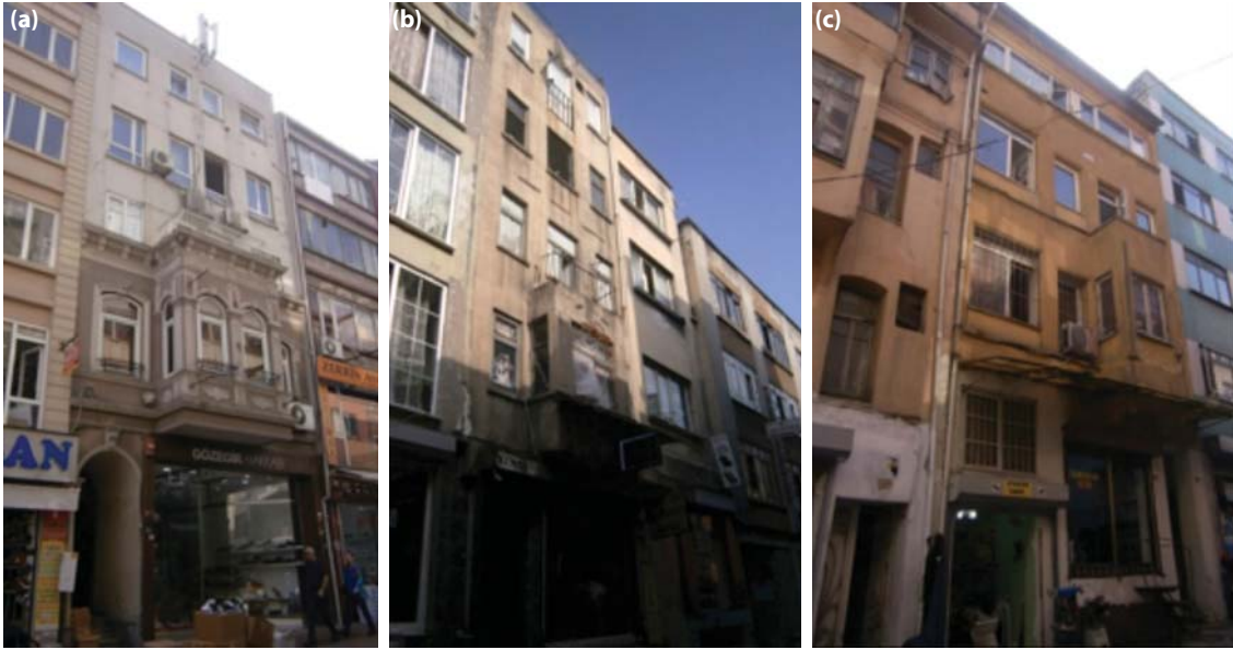
Şekil 27. 217 Ada 10 Parsel (a), 218 Ada 3 Parsel (b) ve 219 Ada 11-12 Parselde (c) yer alan özgünlüğünü büyük ölçüde yitirmiş tescilli yapılar [yazara aittir].
