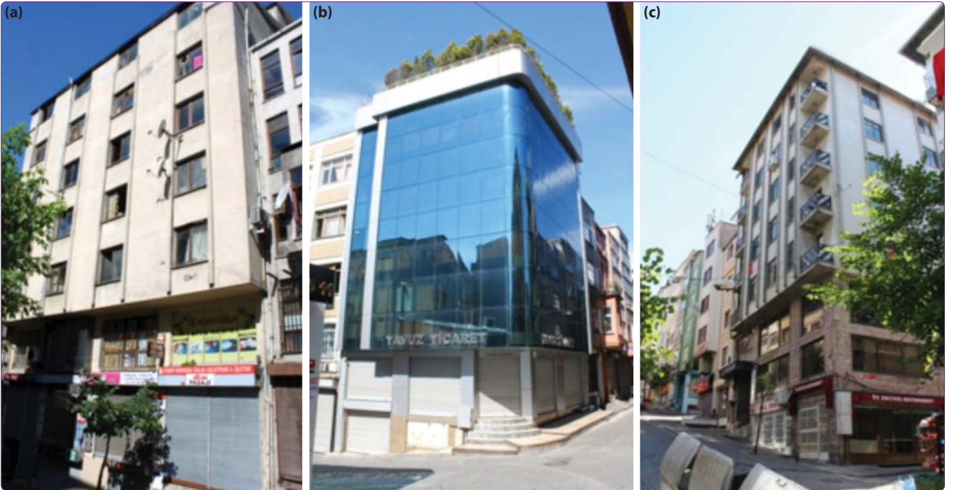
Şekil 33. 196 Ada 30 Parsel (a), 195 Ada 27 Parsel (b) ve 174 Ada 45 Parselde (c) yer dokuya uyumsuz yeni yapılar [yazara aittir].
