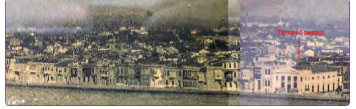
Şekil 10. Yapının olasılıkla inşası esnasında çekilmiş bir hava fotoğrafı. 25
