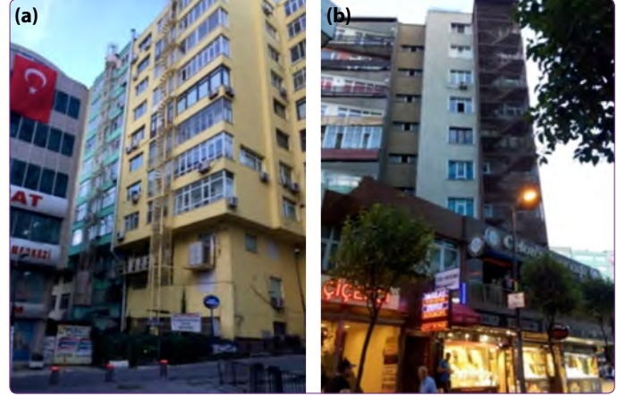
Şekil 8. (a) Dairesel merdiven kullanımı. (b) Merdivenin aydınlatılmaması.
