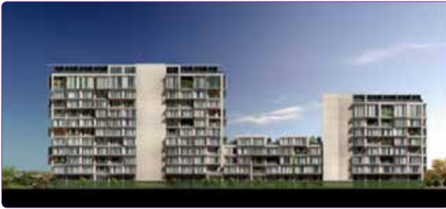
Şekil 14. Levent Loft cephe görünümü.
