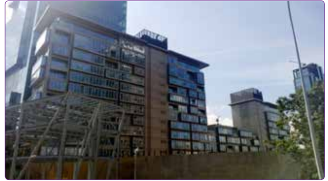
Şekil 16. Levent Loft Binası kuzey cephesi.
