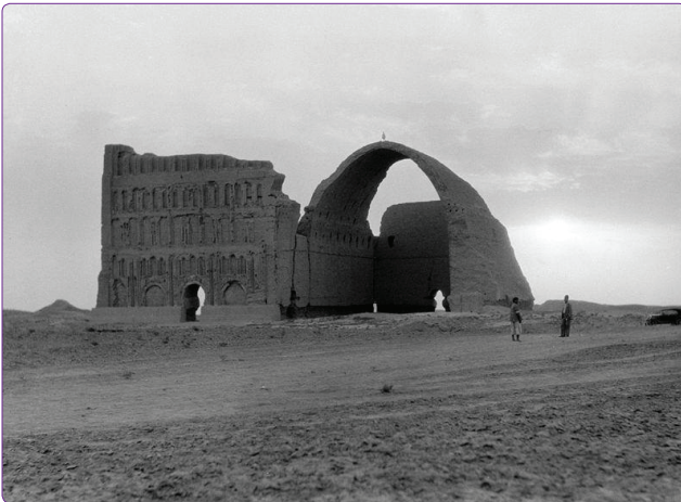
Şekil 2. Tak-ı Kısra. http://en.wikipedia.org/wiki/File:Ctesiphon,_Iraq_(2117465493).jpg
