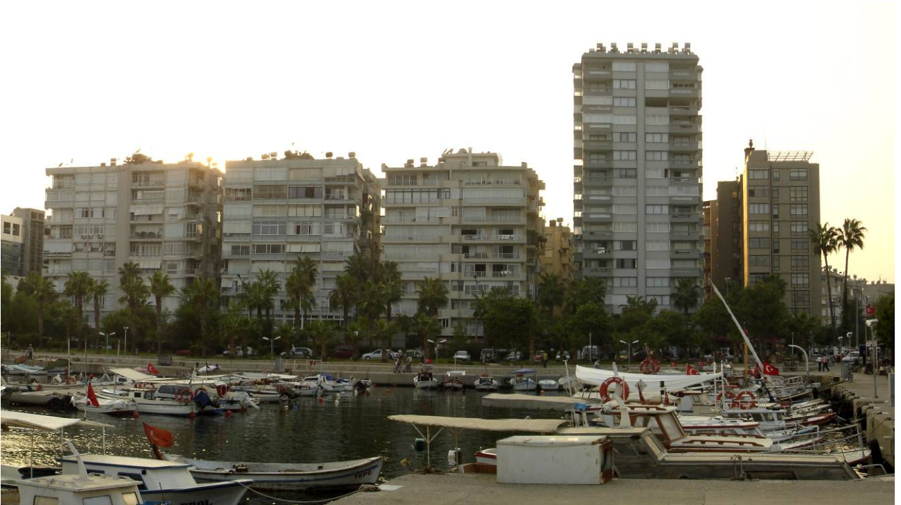
Şekil 11: İnceleme alanında uygulanan ikinci seçenek sonucunda 16 katlı yapının inşaatı tamamlanmıştır ve günümüzde kullanılmaktadır.
