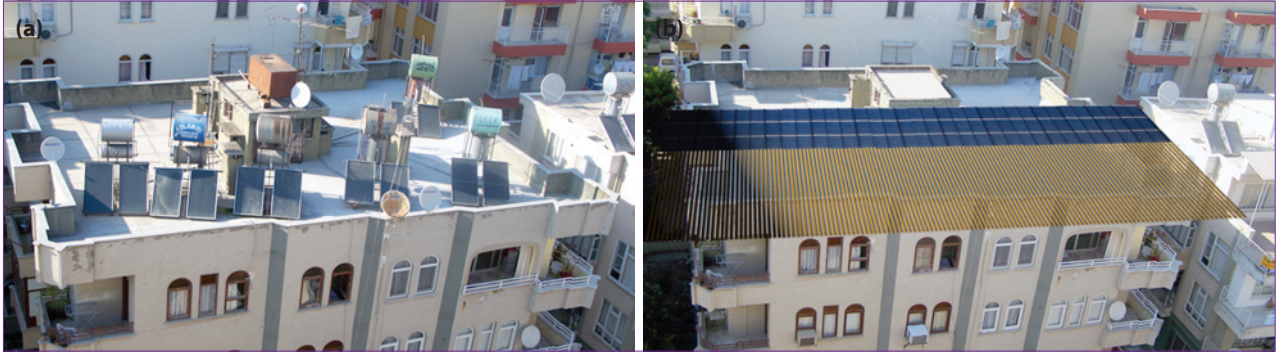
Şekil 13. (a, b) Varolan sistemlerin merkezi sistem ve pergola ile bütünlük olarak yenilenmesi.
