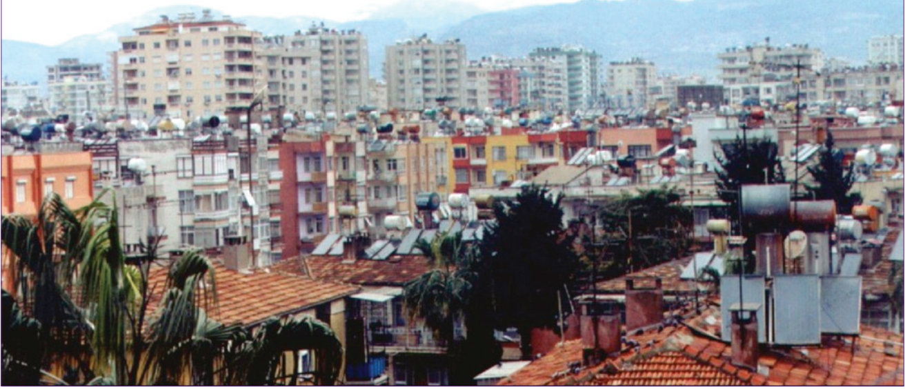
Şekil 1. Kentlerde güneş enerjili su ısıtma sistem sorunsalı.
