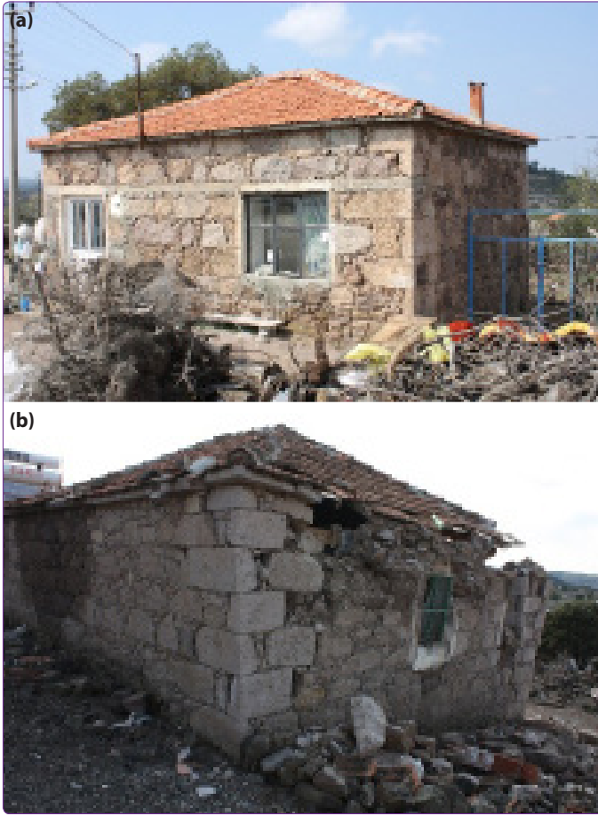
Şekil 17. Hatıllı ve hatılsız duvar örnekleri. (a) Betonarme hatıllı hasarlı yapı örneği. (b) Hatılsız hasarlı yapı örneği.
