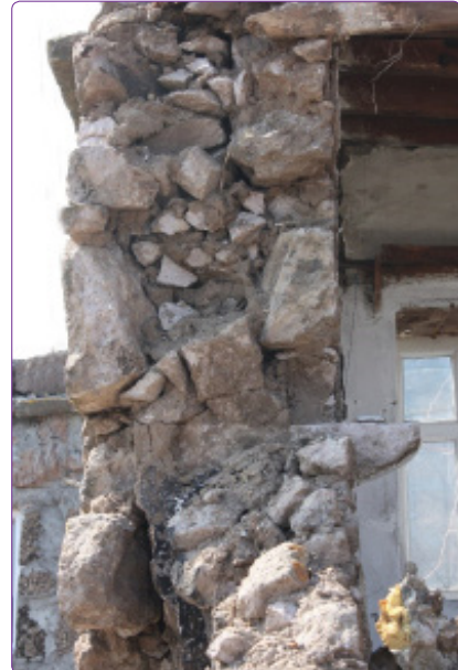
Şekil 7. Bölgede yapılan taşıyıcı taş duvarların kesiti.
