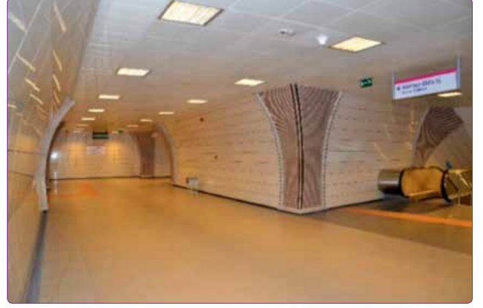
Şekil 21. Kartal Metro İstasyonu'nda duvar kaplaması.
