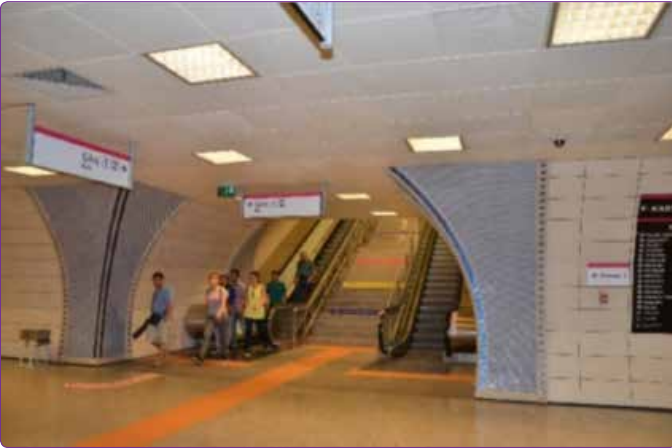
Şekil 20. Kadıköy Metro İstasyonu'nda duvar kaplaması.
