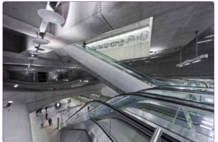
Şekil 6. Budapeşte Kalvin Ter Metro İstasyonu. 23
