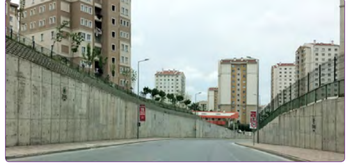
Şekil 3. Bölgede sıklıkla karşılaşılan yüksek istinat duvarlı yerleşimler.
