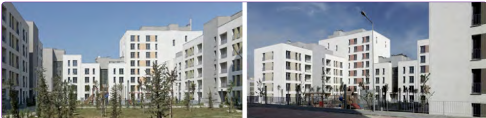
Şekil 13. Blok girişlerinin yer aldığı iç bahçeler.
