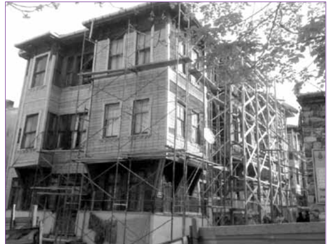
Şekil 3. Dış cephesi KUDEB tarafından yenilenen bir konut.
