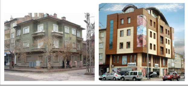
Şekil 4. Alanda yıkılan bir yapı yerine yapılan işlev değiştirilmiş bina örneği (Eldek, 2012).
