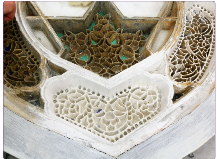
Şekil 14. Kayıtlarındaki kir birikimi zımpara ile aşındırılarak temizlenen bir revzen (Mehmet Uğuryol Arşivi, 2012).
