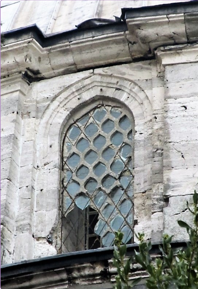
Şekil 10. Dışlık kayıtlarında demir donatının bozulmasından kaynaklanan parçalanmalar (Ayazma Camisi) (Drahşan Uğuryol Arşivi, 2016).
