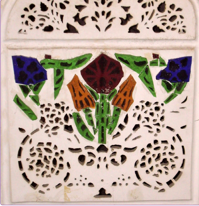
Şekil 9. Oyma tekniği kullanılan revzene arkadan uygulanan camların alçı ile sabitlenmeden önceki görünümü (Drağsan Uğuryol Arşivi, 2011).
