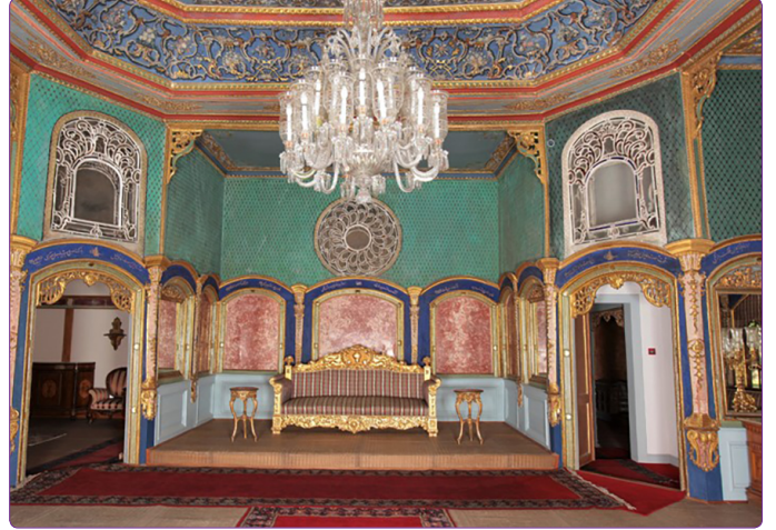
Şekil 4. Aynalıkavak Kasrı'nın iç duvarlarında bulunan çift taraflı revzenler (Draşan Uğuryol Arşivi, 2016).
