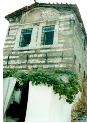
Fodlacı Sokak'ta Bulunan Kagir Yapı –F2-
