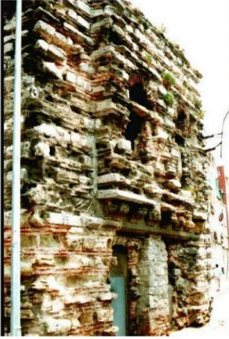
Alişan Sokak'ta Bulunan Kagir Yapı –F3-
