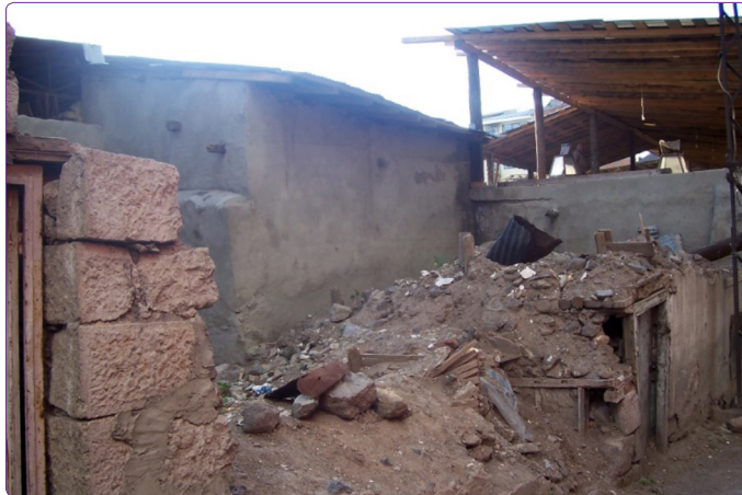
Şekil 22. Mevcut mutfak kısmının yerindeki yıkılan yapı (2013) (Vakıflar Bölge Müdürlüğü Dijital Arşivi, 2013).
