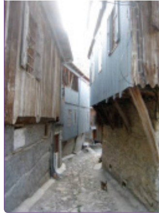
Şekil 10. Damların ve cephelerin sac malzeme ile kapatılması.
