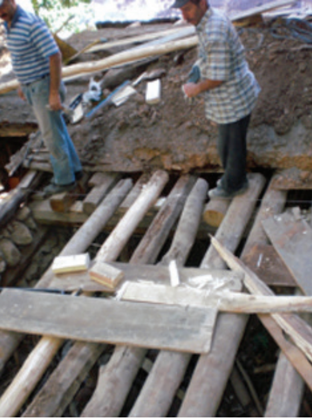
Şekil 13. Ahşap tavan kirişlerinin onarım aşaması.****
