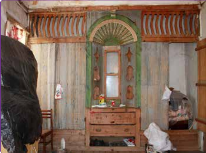
Şekil 40. Yüklük ve Şerbetlik örneği (Keskin, 91 ada 5 parsel). 57
