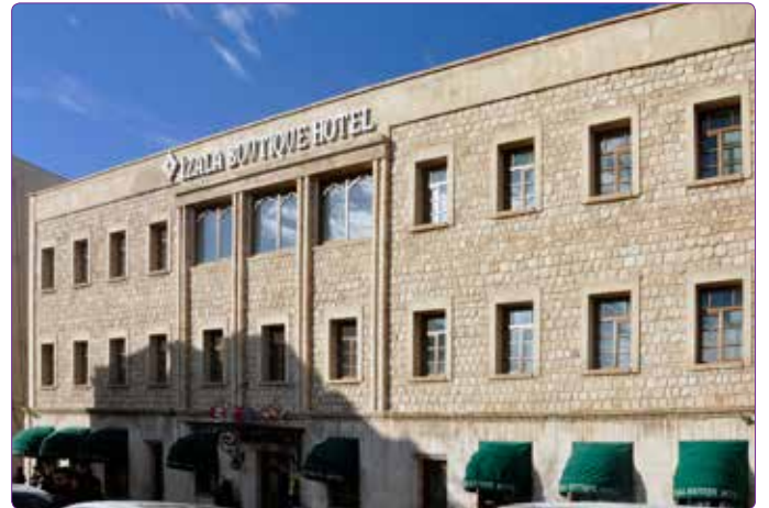
Şekil 38. Halkevi binası restorasyon sonrası cephesi, 2011.
