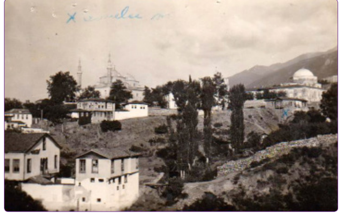
Şekil 20. Yeşil Medrese ve çevresindeki tarihi ve doğal doku. Bursa Kültür Varlıklarını Koruma Bölge Kurulu arşivinde ulaşılan bu eski fotoğraftan çevreye ilişkin veriler tespit edilmiştir.
