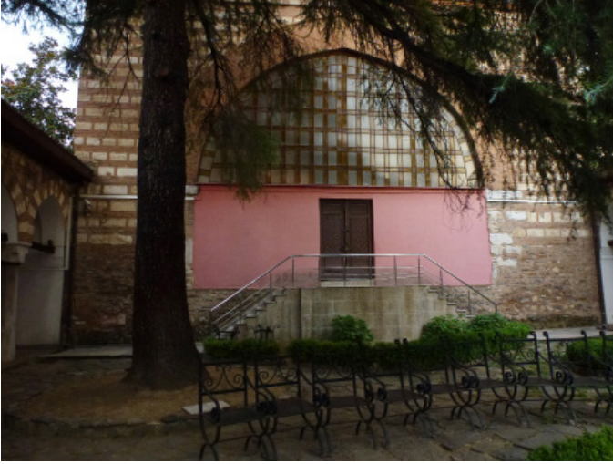
Şekil 7. Avludan ana eyvan/derslik cephesinin görünüşü.
