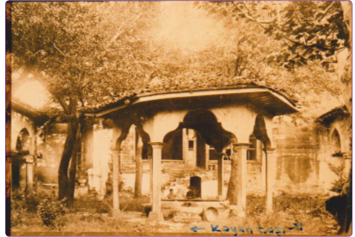
Şekil 17. Avluda şadırvan ve ana eyvana giriş (Bursa Kültür Varlıklarını Koruma Bölge Kurulu arşivinden alınan bu fotoğrafta, dershanenin altında basık kemerli girişi olan bir mekan tespit edilmiştir).
