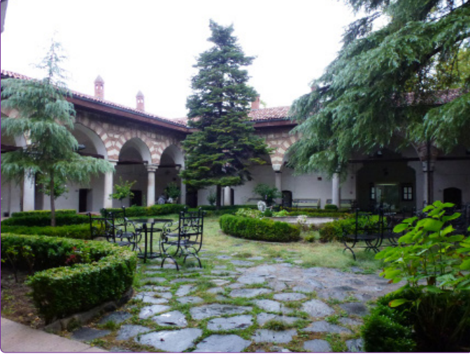
Şekil 3. Avlu, havuz ve revakların görünümü.
