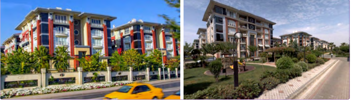
Şekil 22. 5. bölge siteyi sınırlayan elemanlar ve site içerisindeki ortak mekanlar (5. bölgede fotoğraf çekimine izin verilmediğinden Yandex haritalar'dan alınmıştır.)
