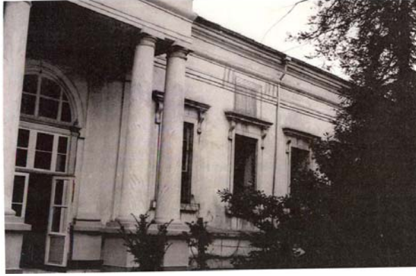
F.23 Gümüşsuyu Hastahanesi'nin doğu cephesi (1967?/I Numaralı K.T.V.K.K. Arşivi)
