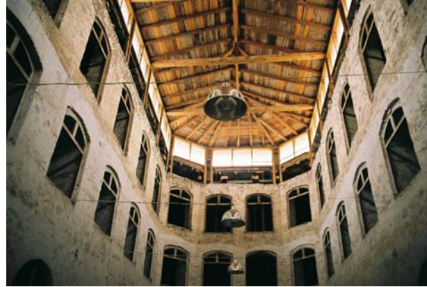
F.14 Küçükyalı'daki askerî depolardan 3. depo yapısının içeriden görünüşü (2004)
