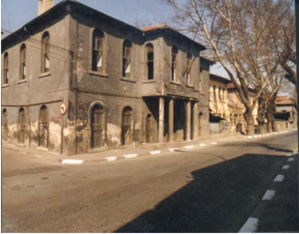
F.7 Eyüp Askerî Rüştîyesi'nin kuzeydoğu ve güneydoğu cepheleri (Eyüp Bld. Arş. Planlama Müdürlüğü Arşivi)
