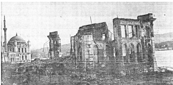
F.5 Yıkılmakta olan Feriye Karakolu'nun güneyden görünüşü (1966/III Numaralı K.T.V.K.K. Arşivi)
