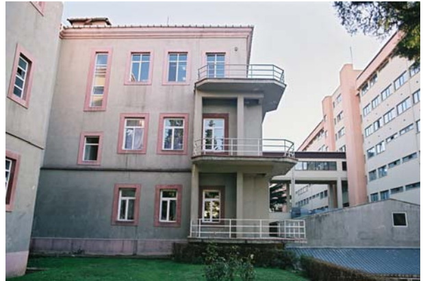
F.22 Haydarpaşa Hastahanesi'nin muhdes balkonları ve güney yönündeki yeni bina (2003)
