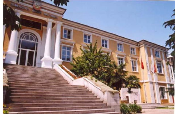
F.24 Gümüşsuyu Hastahanesi'nin doğu cephesindeki muhdes üst kat pencereleri, giriş merdivenleri ve giriş kapısı (2001)
