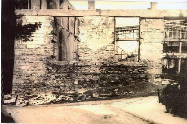
F.27 Kuleli Kışlası manejinin onarım öncesi ayakta kalan kâgir beden duvarları (tarihsiz/III Numaralı K.T.V.K.K. Arşivi)
