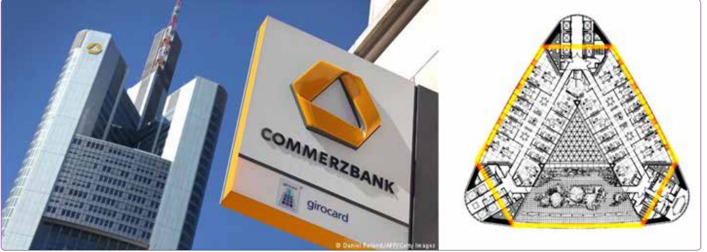
Şekil 15. Commerzbank, Frankfurt Merkez Binası – Norman Foster (Kaynak: www.fosterandpartners.com).
