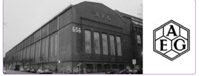
Şekil 5. AEG tirübün fabrikası binası ve logosu (Behrens, P., 1912) (Kaynak: https://discoveringdisegno.wordpress.com/2012/11/10/behrens-aeg-fabrik-humboldthain/ )
