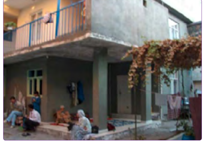
Şekil 8. Betonarme eklenti.
