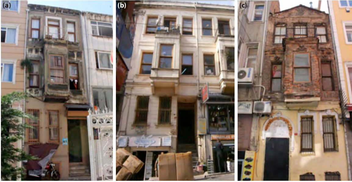
Şekil 26. 196 Ada 17 Parsel (a), 217 Ada 16 Parsel (b) ve 191 Ada 26 Parselde (c) yer alan özgünlüğü korunmuş tescilli yapılar [yazara aittir].
