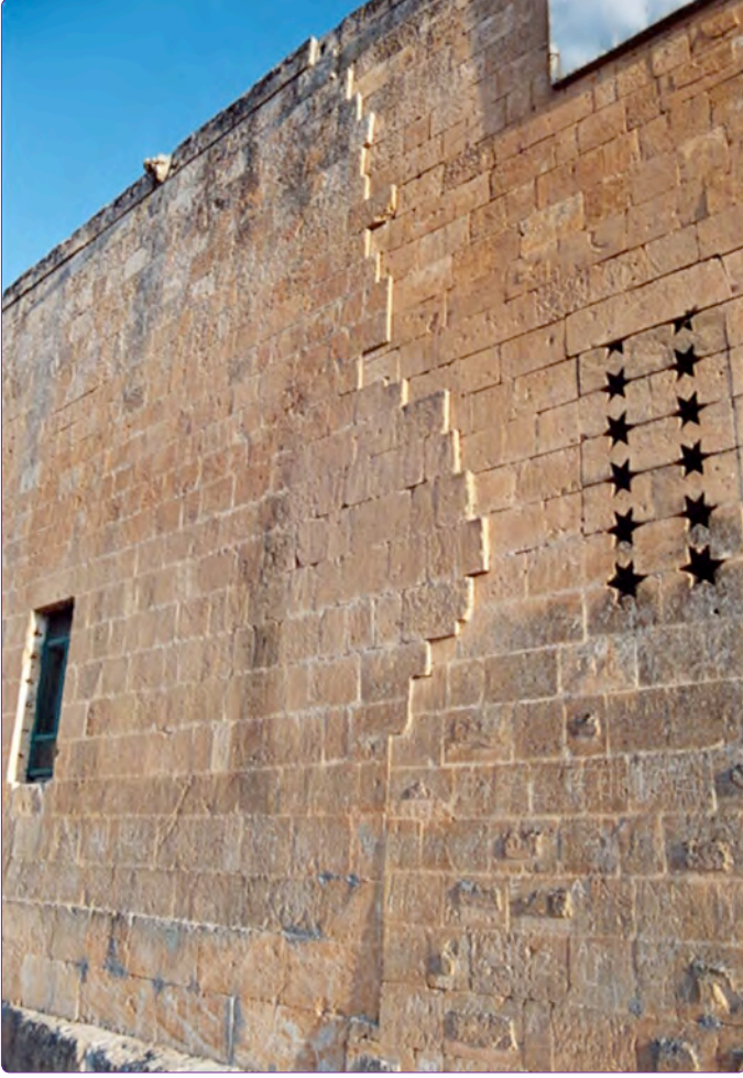
Şekil 26. Kuzey Cephesi – Tamirat İzleri, Duvardaki Yüzeysel Farkı (1993).
