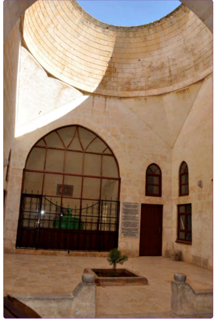
Şekil 17. Avlu Üst Örtüye Geçiş ve Yarım Kubbe.
