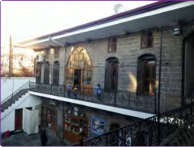
Şekil 24. Betonarme saçak ve gezemek.
