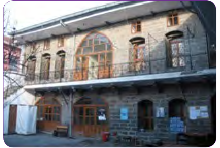
Şekil 20. Eyvanların kapatılması.
