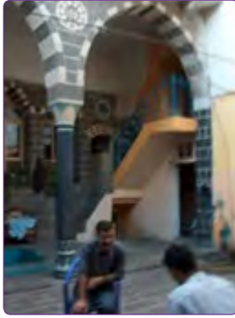
Şekil 12. 22 nolu evde kat eklemesi.
