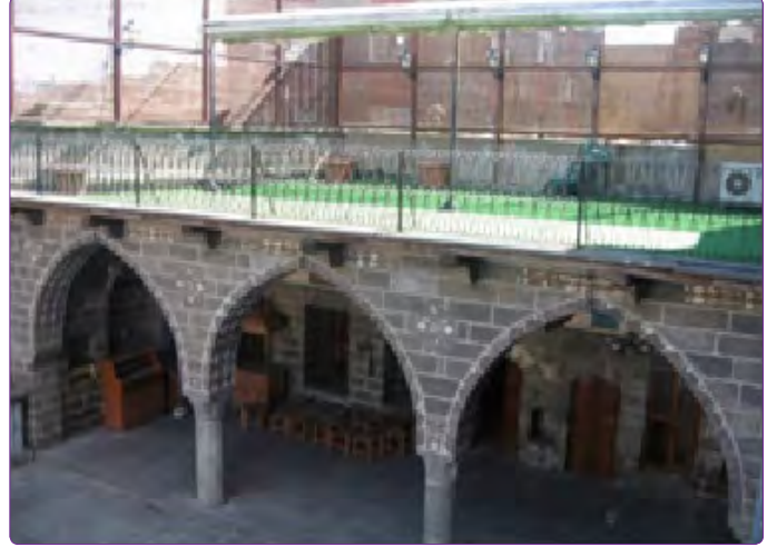
Şekil 25. Suni yeşil çim ile kaplanmış evin damı.
