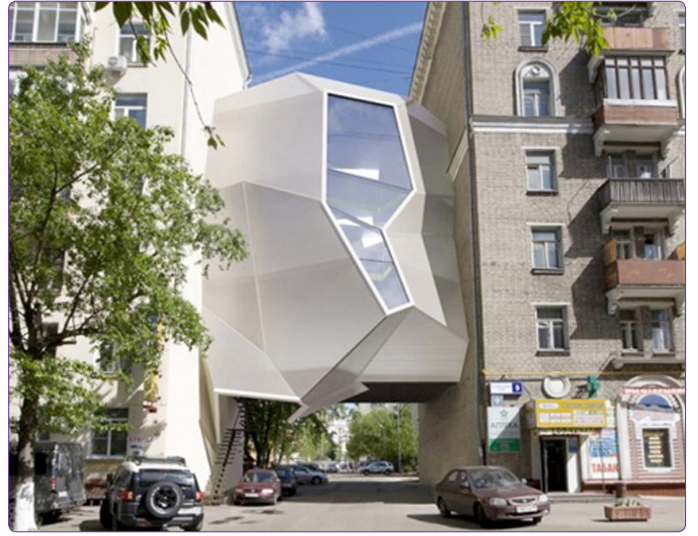
Şekil 2. İki binanın arasındaki boşluğa yerleşen bir ofis, Moskova.
